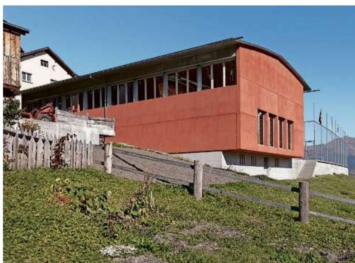
Die Mehrzweckhalle in Tschlin zeugt von der Suche nach einer zeitgemässen Reaktion auf Tradition und Topografie. Bild: Ralph Feiner
