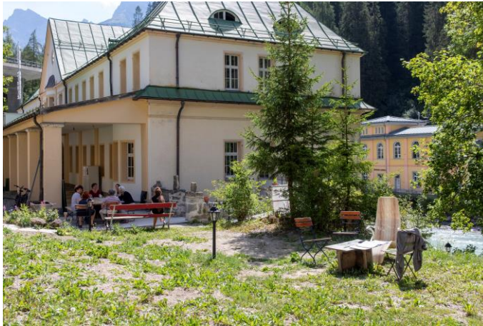
Fundaziun Nairs Aussenansicht, Fundaziun Nairs, Foto: Nelly Rodriguez
