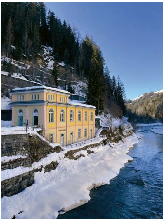
→ Ganzjährig offen: Die Chasa Carola birgt die Fassung der Carolaquelle. Dazumals wurde hier auch Strom für die elektrische Beleuchtung erzeugt.
